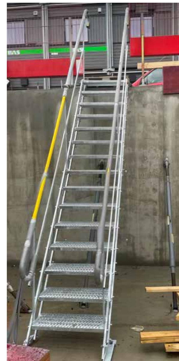
TRYGG PASSASJE: Flyttbare og stabile aluminiumsstiger er tatt i bruk på byggeplassen i stedet for provisoriske løsninger.
