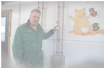
– Før kunne det renne kondensvann av vegg, men nå er det tørt og fint og det er lite jobb med å holde det rent i bingene, sier Erik Tofastrud.
