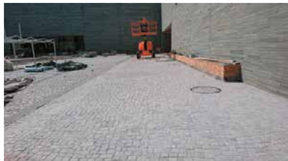
Nye Nasjonalmuseet med vannbåren snøsmelting lagt direkte i BETO naturSETTE-D
