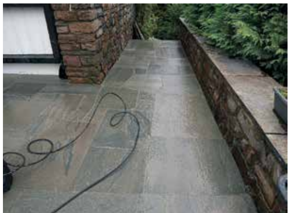
Noen cm med naturSETTE-D gir stabilitet og fuging med BETO naturFUG vil lede bort vannet
