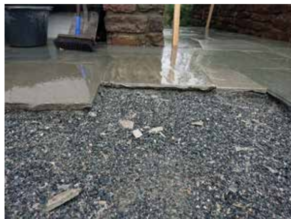
Noen cm med naturSETTE-D gir stabilitet og fuging med BETO naturFUG vil lede bort vannet
