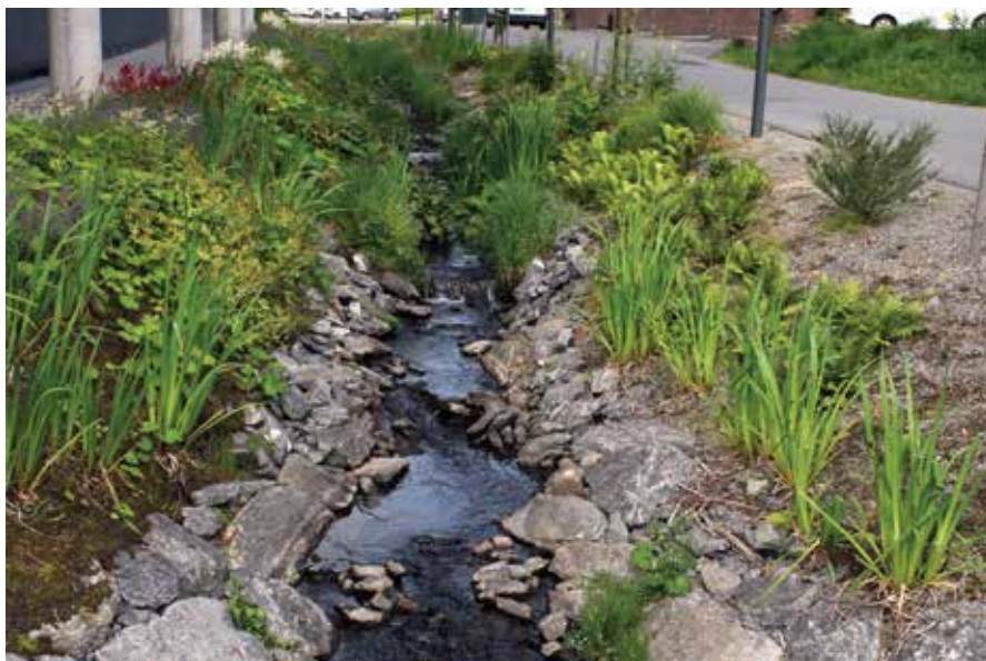
Drengsrudbekken i Asker kommune, som lå i rør, ble åpnet og etablert med frodig kantvegetasjon og substrat av naturstein. Foto: COWI
