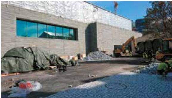
Nye Nasjonalmuseet med vannbåren snøsmelting lagt direkte i BETO naturSETTE-D
