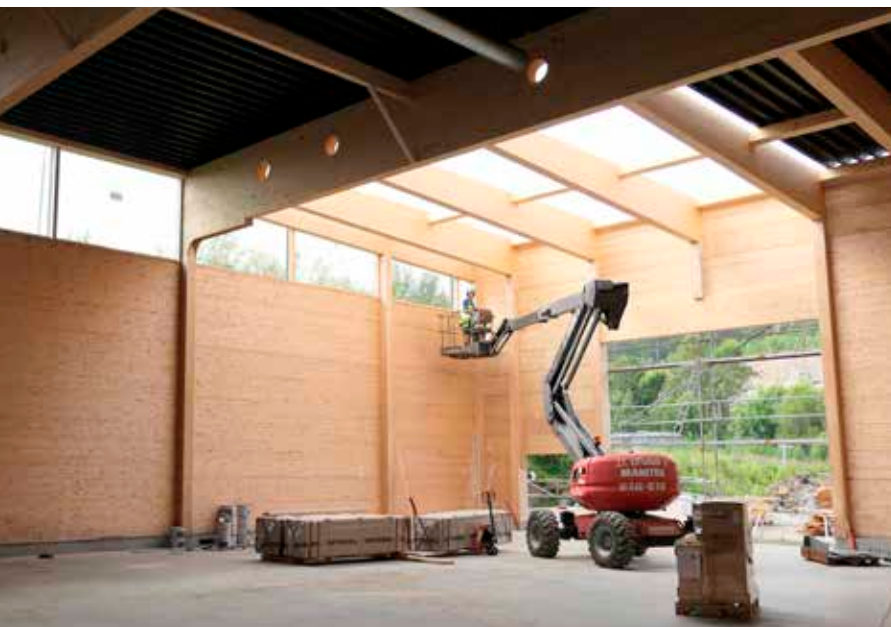
Aanesland fabrikk sparer 46 prosent av CO2-utslippene ved å bygge slik i massivtre. Dessuten får bygget en helt annen "atmosfære".
